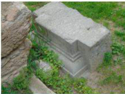
Foto rimozione croste nere ex post
