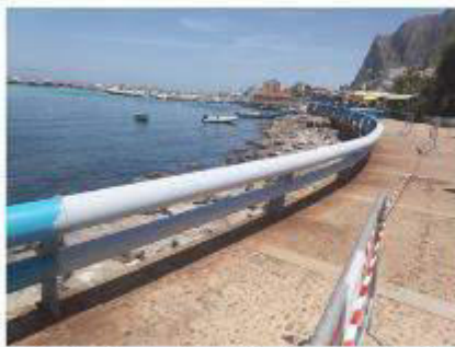
Foto trattamento preliminare tubolari con prodotto Zincofond
