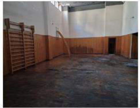
Foto Scantinato ex post
