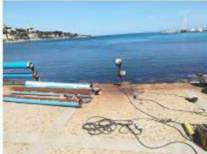
Foto rimozione tubolari ammalorati
